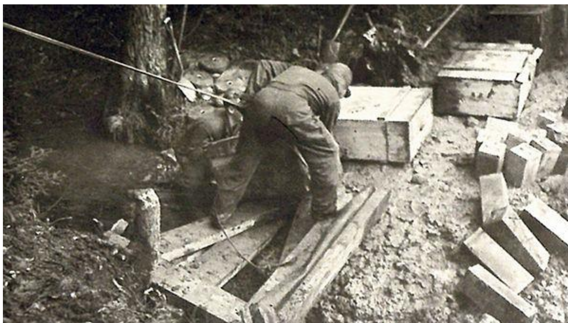
Obr. 4: Vyzvedávání obsahu tzv. Frankovy štolý americkou armádou
